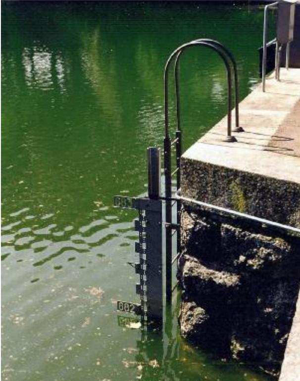
Figure 1.03-1: Echelle limnimétrique
