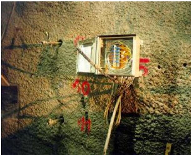
Figure 2.16-3: Installation dans un forage. Seuls les câbles de connexion ressortent du forage même et sont acheminés dans un boîtier de connexion.
