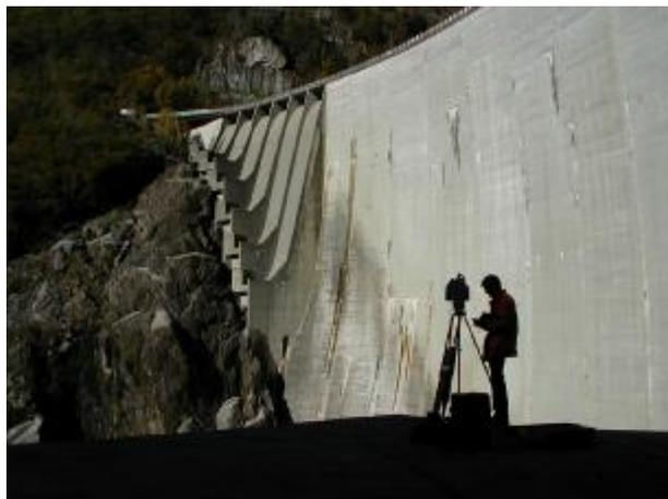
Figure 2.04-1: Le Laser-Scanning permet de relever des surfaces de barrage en béton et par exemple de situer les dégâts.
