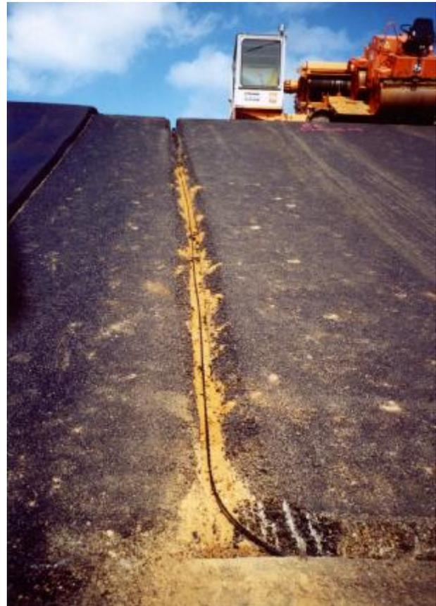
Figure 1.15-2: Installation du câble de mesure sous le goudron d'étanchéité d'une digue.
