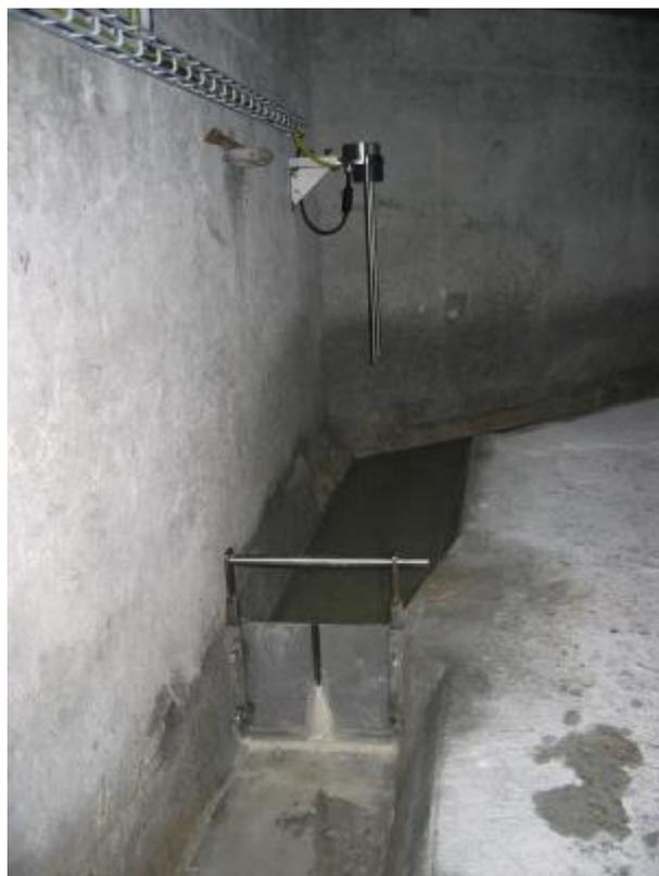
Figure 3.02-2: Déversoir avec sonde à ultrasons
