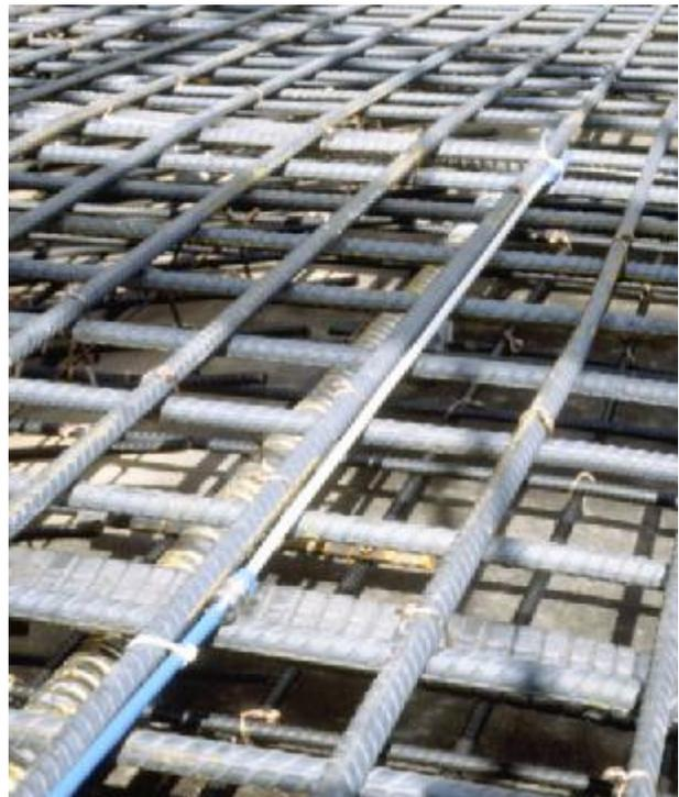
Figure 2.16-2: Installation dans le béton. Le capteur est attaché à une barre d'armature.
