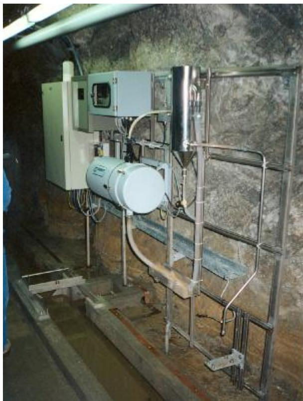
Figure 3.11-1: Mesure automatique de turbidité combinée avec une mesure automatique des infiltrations
