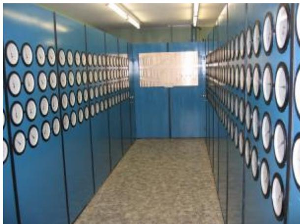
Figure 3.10-2: Chambre de mesure pour piézomètres hydrauliques
