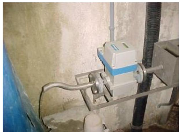
Figure 3.03-2: Appareil de mesure du flux. Le tube de sortie est recourbé vers le haut afin qu'il soit toujours rempli d'eau et qu'un écoulement permanent soit assuré.
